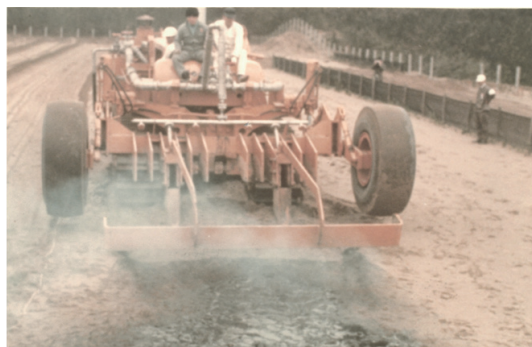
第6図 アスファルトバリアーによる土層改良 (昭和47年)
