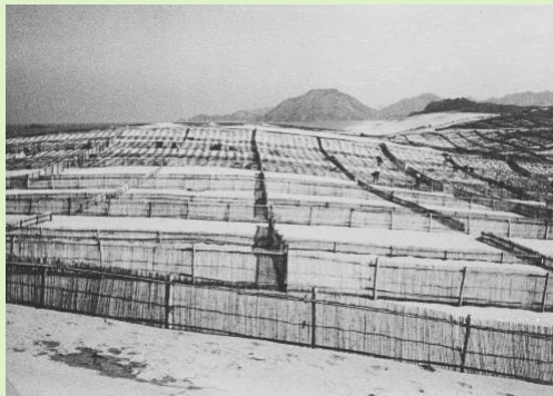
堆砂垣の風下に設置された静砂垣。風を弱め、砂の動きを静めることが出来る。 昭和27年(1952)頃
