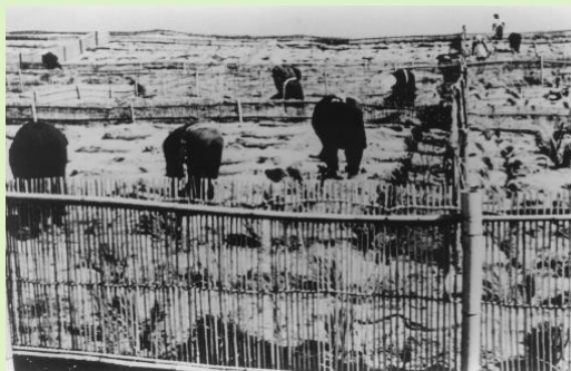
堆砂垣、静砂垣の設置と植林 昭和27年(1952)頃
