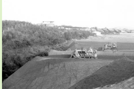
ブルドーザーを用いた大規模な圃場の整地。 谷を埋めて、平坦な土地を造成。 (昭和41年:1966)
