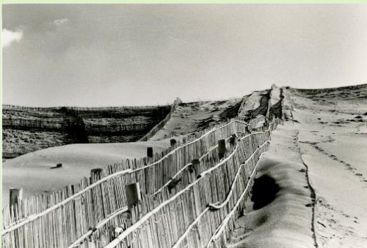
海岸線に平行に設置された堆砂垣。堆砂垣の周囲に砂が堆積し、最終的に人工砂丘を作り上げることが出来る。 昭和27年(1952)頃
