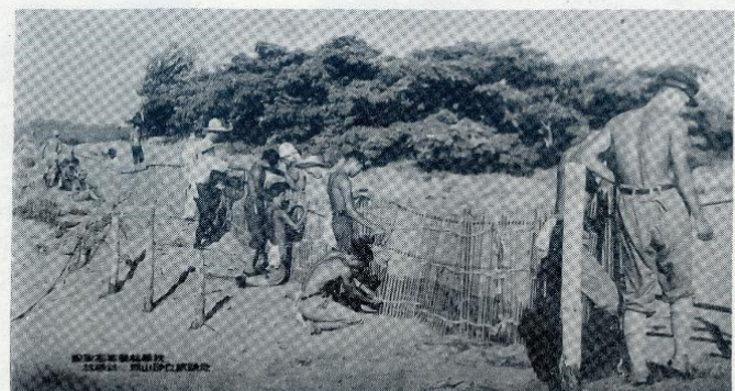
砂防垣作業 (湖山砂丘試験地)
