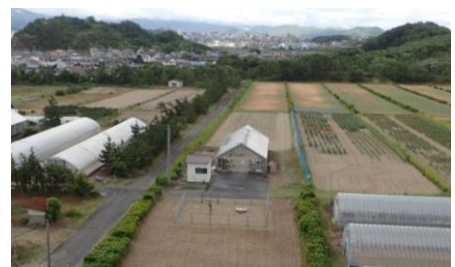
新気象観測露場(写真中央手前のフェンスに囲まれたところ)と周辺環境。
