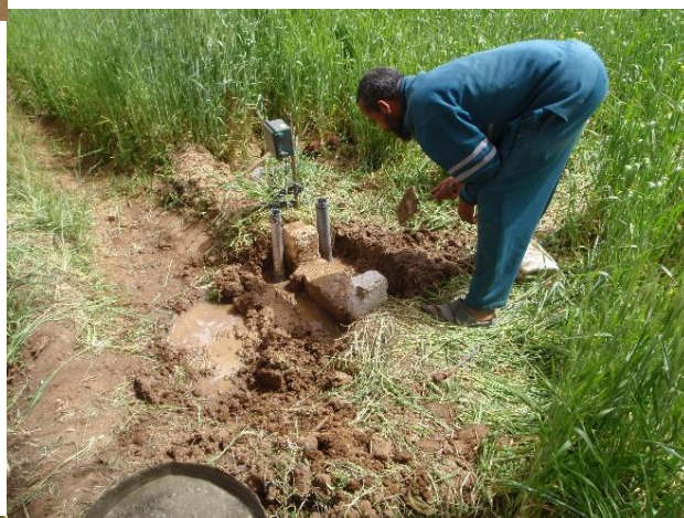
ダハラオアシスの圃場に流入する灌漑水の流量を測定するための水路及び水位計を設置しているところです。(2014 年 3 月 撮影：木村玲二)
