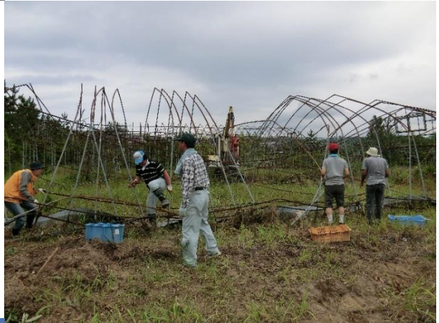
一斉清掃での圃場老朽ハウスの撤去 (2012年7月20日 乾燥地研究センター所蔵)
