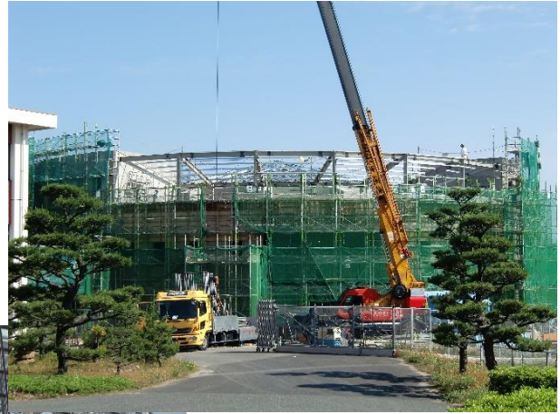
アリドラボ工事 (2010年6月9日 乾燥地研究センター所蔵)
