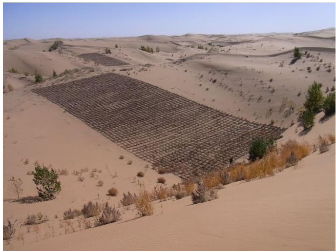
中国内蔵クブチ砂漠に設置した在来樹木植栽試験地。飛砂固定のための草方格施工直後の写真（2012年10月 撮影：山中典和）
