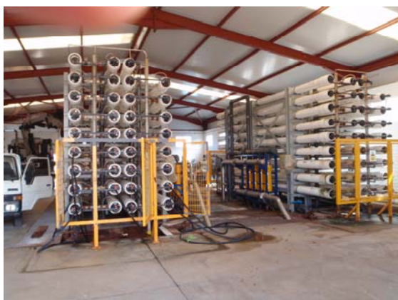
逆浸透膜装置
