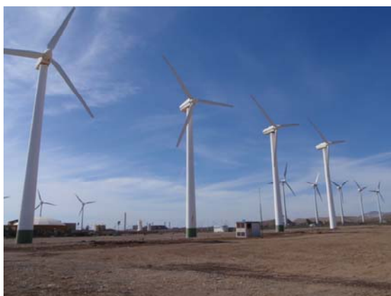
施設内風力発電
