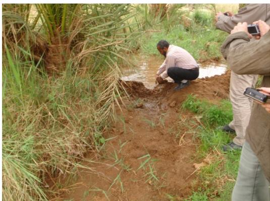
土壁による灌漑水の遮断
