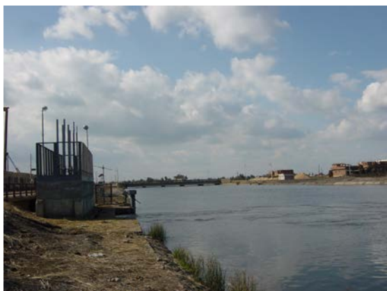
排水路と canal の合流地点
